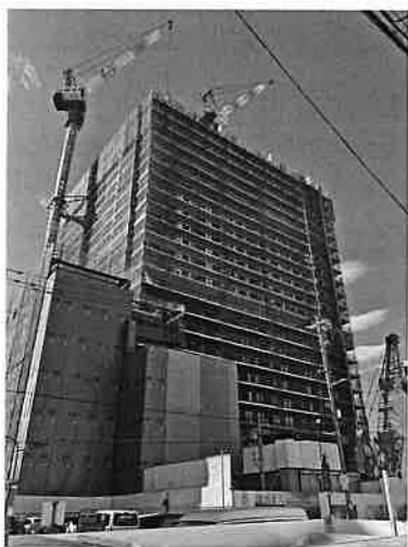
複合施設建設現場…令和6年9月撮影 (左側テント部分に新事務所が入る)
